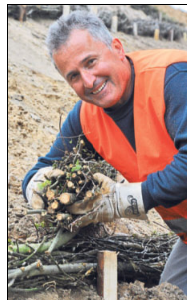
Ein Bündel aus Zweigen und dünnen Ästen: Firmenchef Nazmi Gashaj (51) zeigt den Aufbau einer Faschine.
