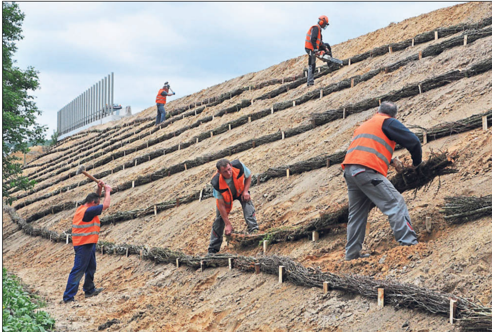
Der schwere Oberboden kann kommen: Auf diesem A-33-Trassenabschnitt an der Brücke Brockhagener Straße haben die Faschinenex-
